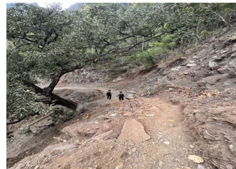
पिपल डाडा देखि सिमलचौर जोड्ने सडक निर्माण योजनाको तस्विर
